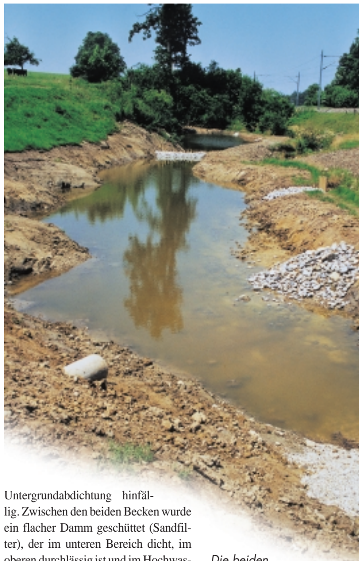
Die beiden Retentionsbecken Hungerbühl kurz nach der Fertigstellung.
